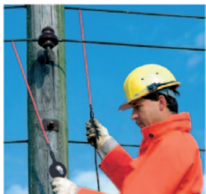
■ Obr. 1 Měření se zkoušečkou vybavenou nástavcem
