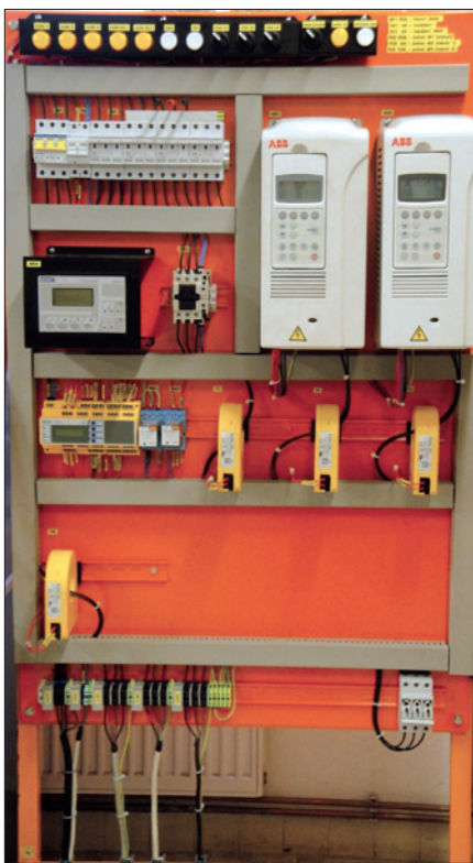
Obr. 1. Zkušební panel pro testování systému lokalizace zemního spojení v síti s izolovaným uzlem
