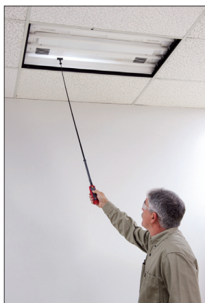
Obr. 2. Testování zářivek na stropě
