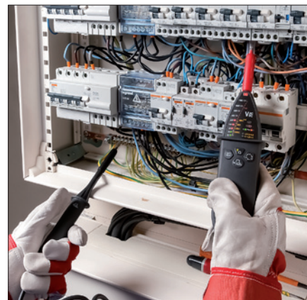
Obr. 4. Měření zkoušečkou s hroty IP2X
