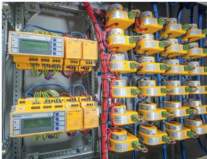
Obr. 3 Pohled na vybavení rozváděče se dvěma RCMS460-D, čtyřmi AN420 a 24x proudovými transformátory W20AB. Toto osazení monitoruje 24 smyček (vývodů).
