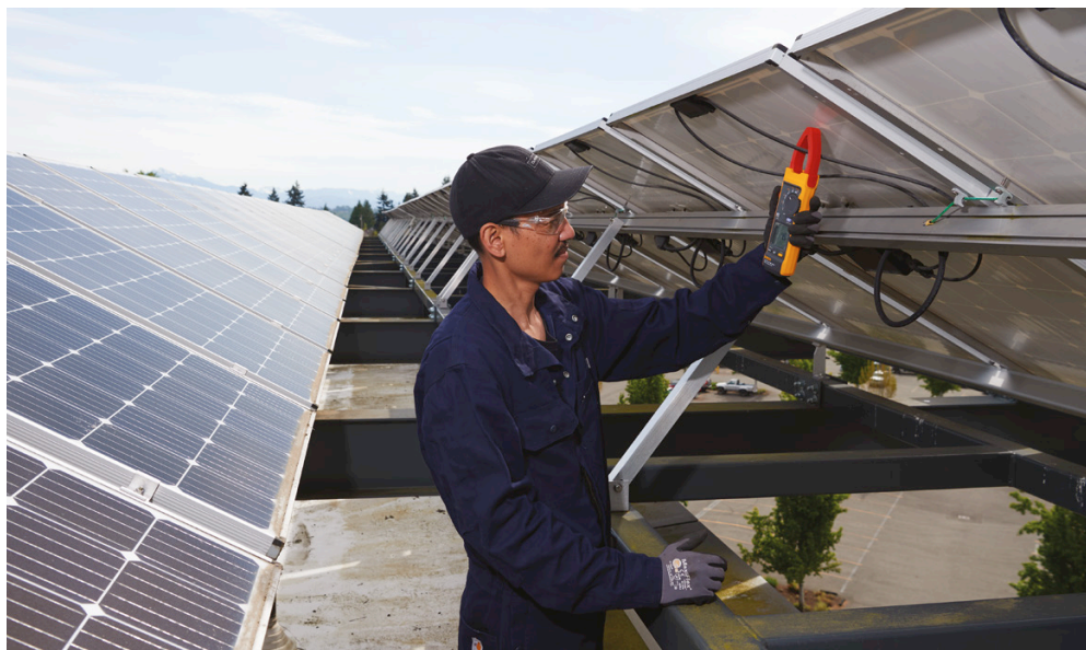
Obr. 2 Využití klešťového multimetru Fluke 393 FC při údržbě solárních panelů
