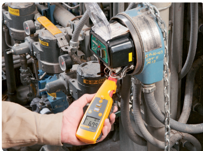
Obr. 2 Měření v procesní smyčce
